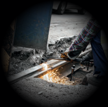
Manutenzione binari & scambi
