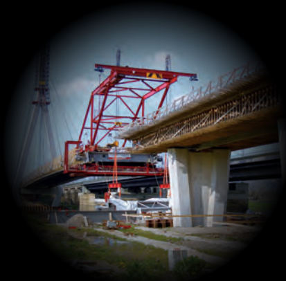
Costruzioni & strutture in acciaio
