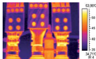
Termografie quadri elettrici, in condizioni operative corrette
